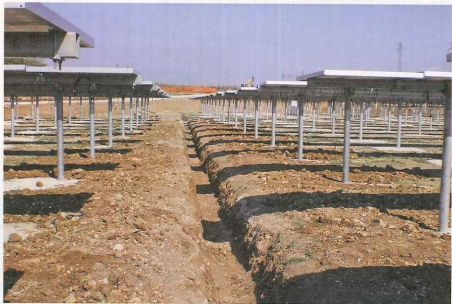
BUILDING BLOCK. Il motore è collocato sui plinti più massicci, che misurano un metro in altezza e quattro in lunghezza e larghezza
